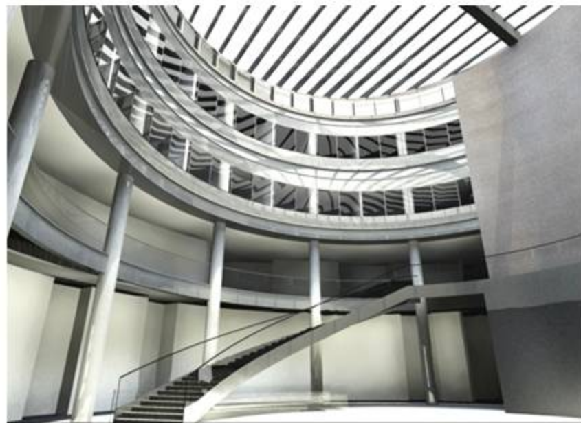
Vista dal piano terreno
