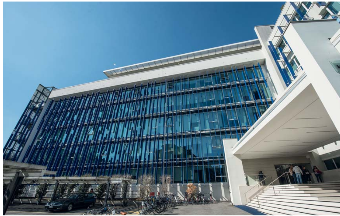
Palazzo Alpitour di via Lugaro
